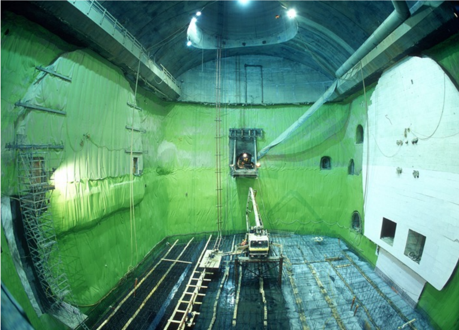
ATLAS Kaverne nach Aushub im Juli 2002
